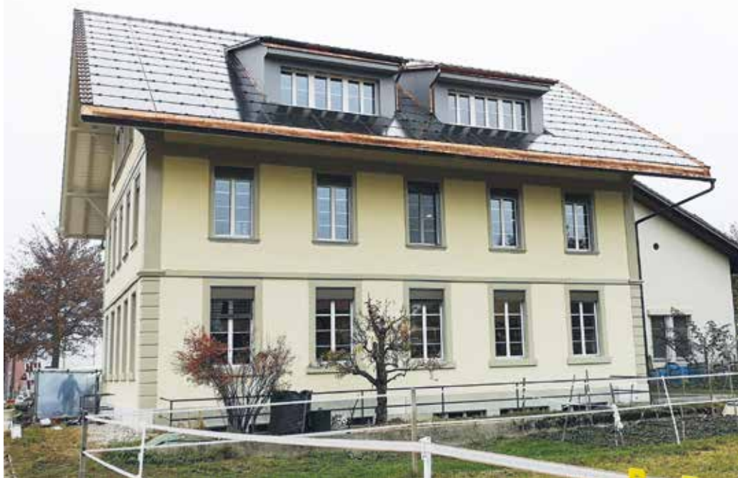
Die Renovation war nötig: Dachisolation, Photovoltaik, Wärmepumpe und Fassadenrenovation sorgen dafür, dass die Biofarm mit Büros, Lager und Verkaufspunkt auch gebäudetechnisch der Umwelt verpflichtet bleibt.
